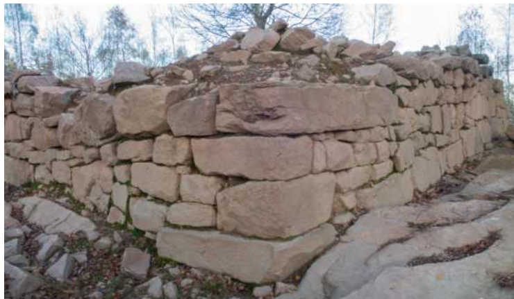
Angle S-W de la construction rectangulaire
