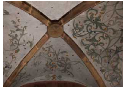
Voûte du chœur
