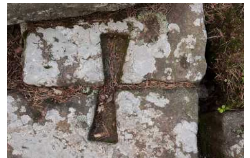
Encoches en forme de queue d'aronde
