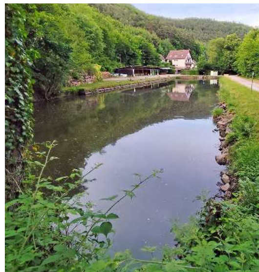
Le réservoir principal
